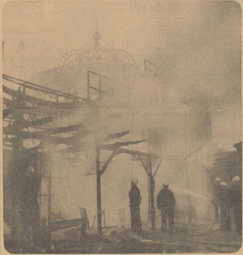
Brandhören på släckningsarbete vid Gröna Lunds berg och dal-bana, som allvarligt skadades. I förgrunden en rad papperslängor, som nästan helt förstördes av elden.
